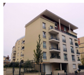
Immeuble rue H. Barbusse 2011
