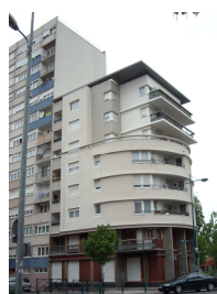
Immeuble transformé au Luth
